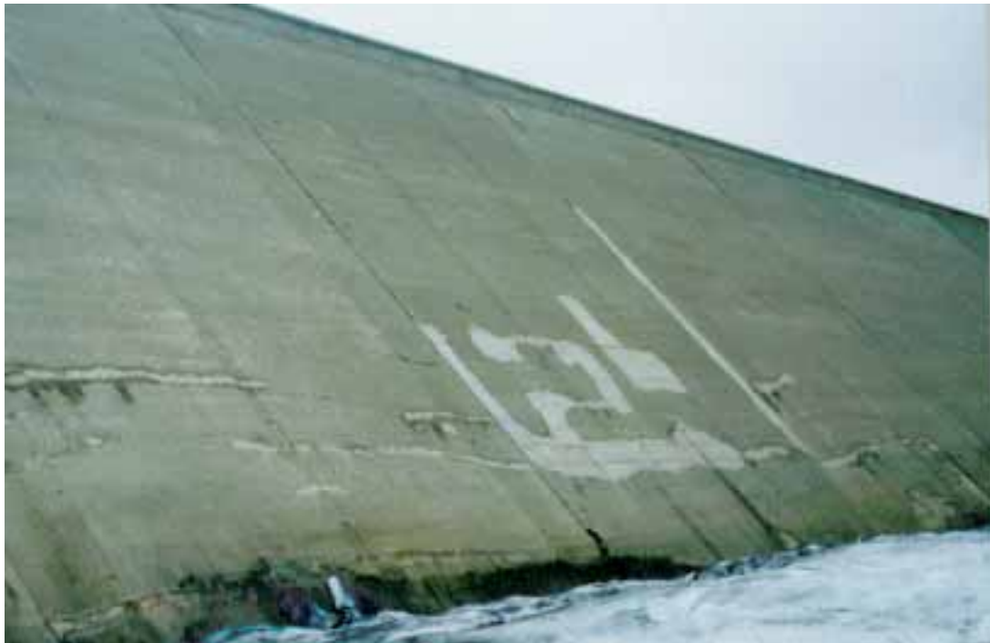
Foto 1 Reparasjoner i damplater sett fra vannsiden
